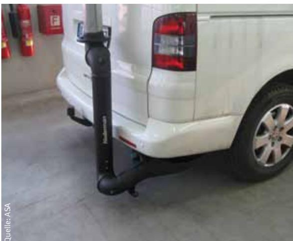
Bild links: Berührungslose Absaugeinrichtung für alle Fahrzeugtypen
