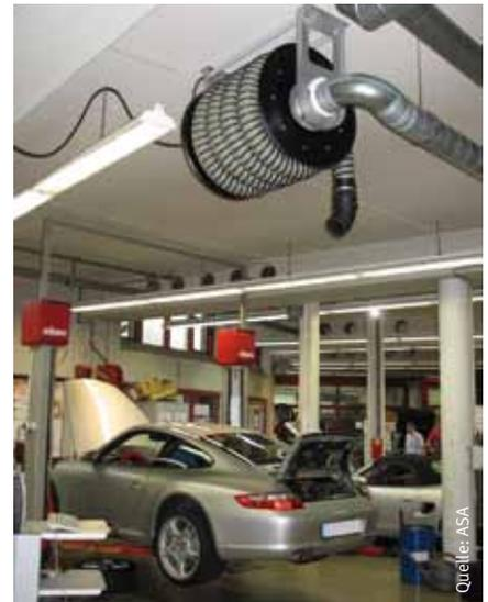
Abgasschlauch - Aufroller mit Hochtemperaturschlauch
